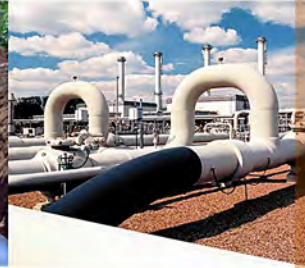
Fabricación de cabezales y trampas p/ gas seco
