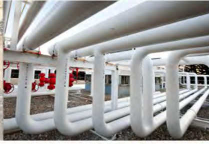
Fabricación de líneas de proceso
