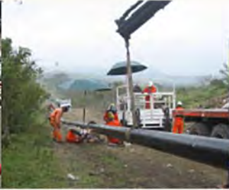
Construcción de gasoductos
