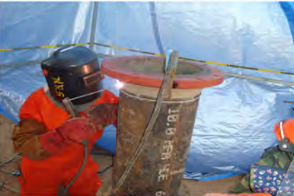
Soldadura calificada en estaciones
