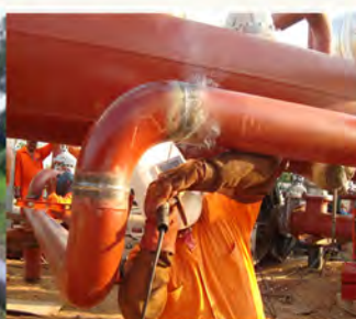
Soldadura calificada en líneas de proceso
