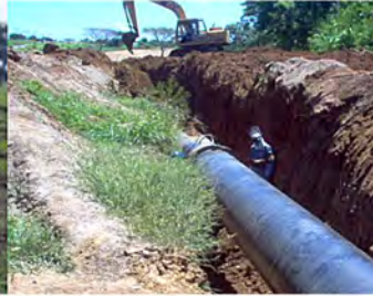
Construcción de oleogasoductos
