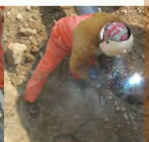
Soldadura en bajas y llegadas
