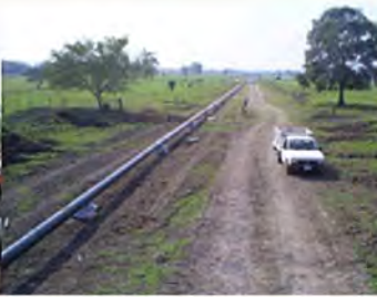
Construcción de líneas de descarga
